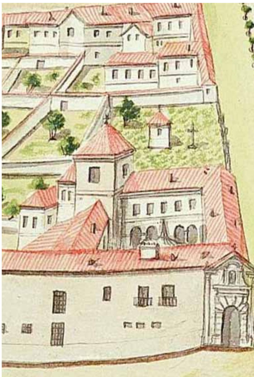
Hospital Real o General de la Resurrección, donde se realizaban las prácticas quirúrgicas. En la parte más alejada de la puerta principal se encontraban las instalaciones docentes y los anfiteatros anatómicos
