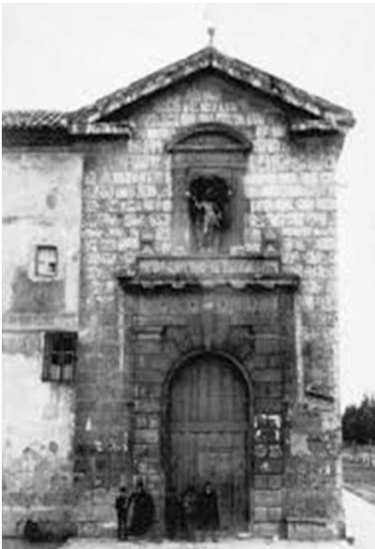
Fotografía de la Puerta del Hospital tomada antes de su demolición.
