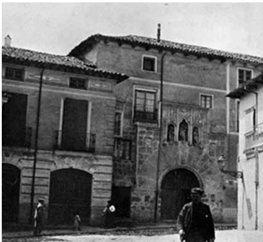
Fachada del hospital antes de ser demolido el edificio, que servía de residencia sacerdotal y se trasladada a la vecina calle San Juan de Dios para dar entrada a otro edificio con el mismo uso
